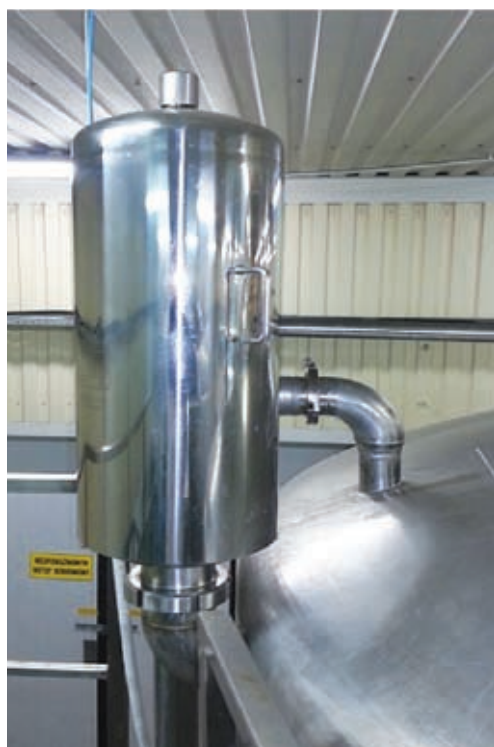
Fot. 1. Widok obudowy oddechowej na zbiorniku; wewnątrz zainstalowane są wkłady oddechowe Pall Emflon PFR
